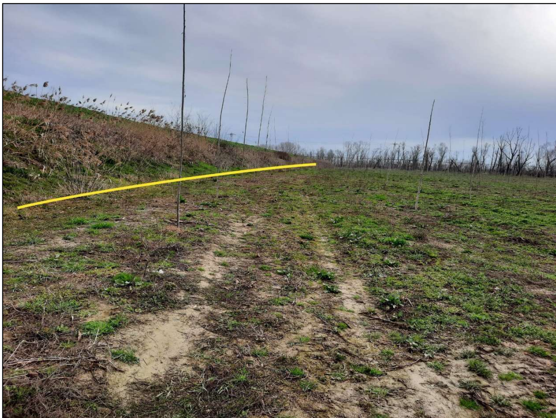
Figura 8 - Foto dell'area d'intervento con vista verso valle – unghia arginale a fiume con ubicazione dell'area di imposta del diaframma (linea gialla).
