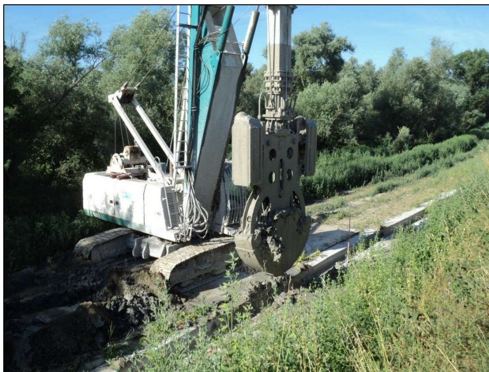
Figura 3 - Fase di scavo del diaframma - intervento di classifica RO-E-1432 – Cavanella Po (Adria, RO).
